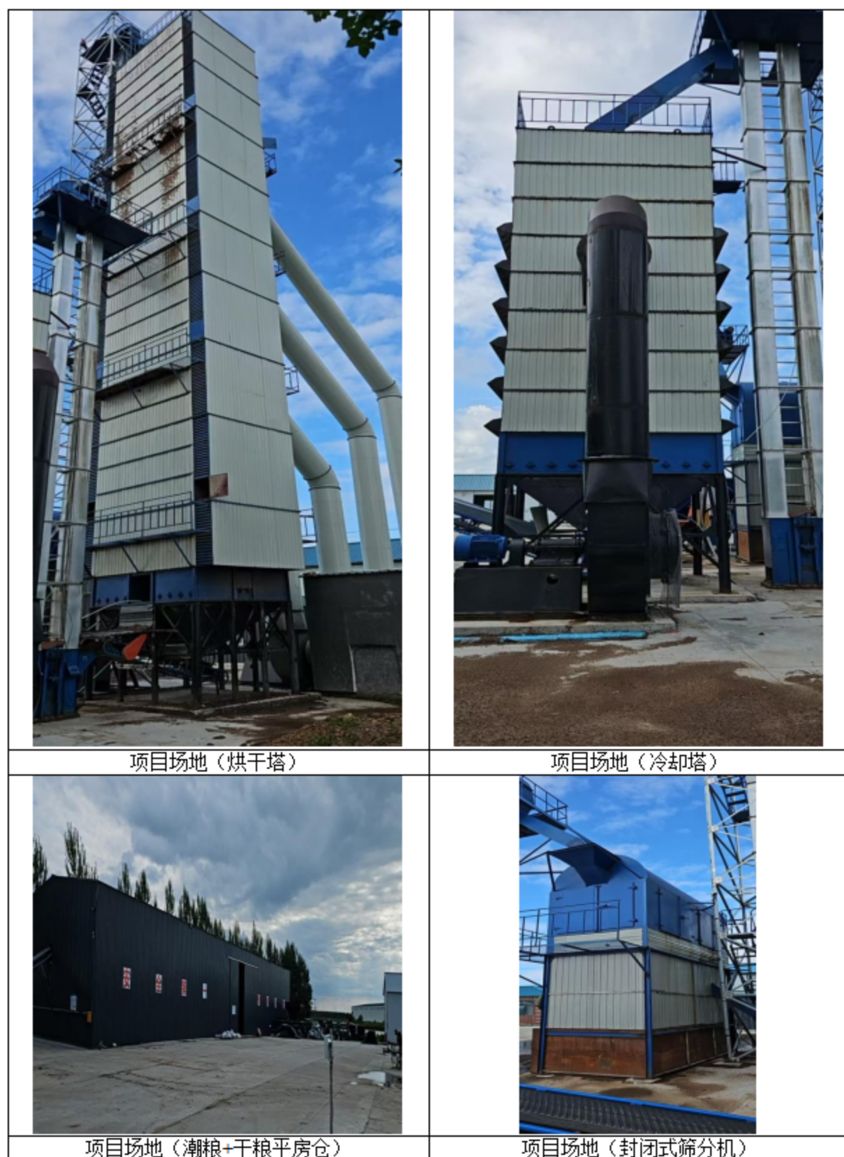
附图 3 项目场地及周边环境现状照片
