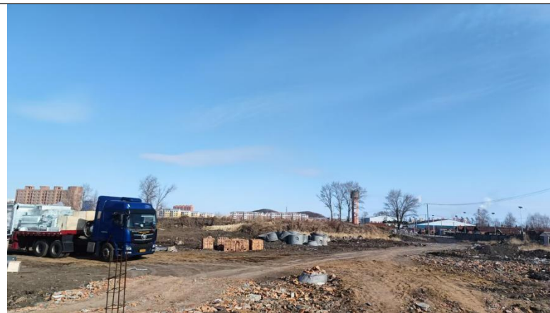
项目北侧为空地
